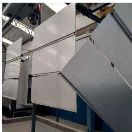
Antes do processo de limpeza
